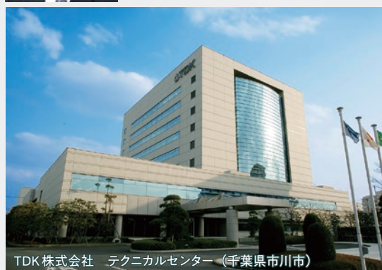
TDK 株式会社 テクニカルセンター (千葉県市川市)
